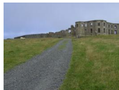
Klosterruinen Downhill house från ca 1880
